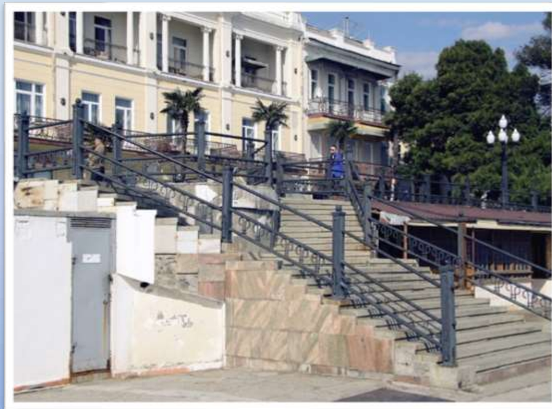
Фундамент круглого киоска и лестница на набережную 2024 г.
